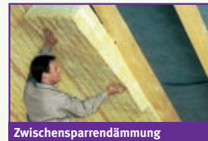
Zwischensparrendämmung
